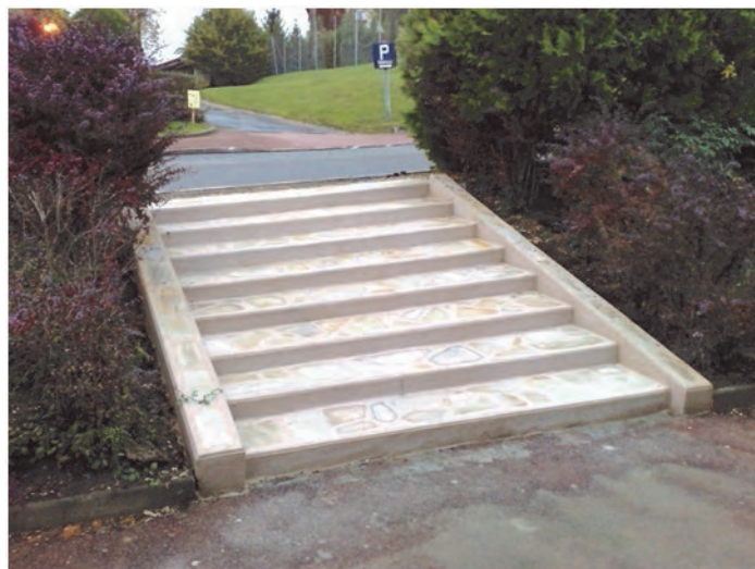
Le nouvel escalier de la salle de fêtes
