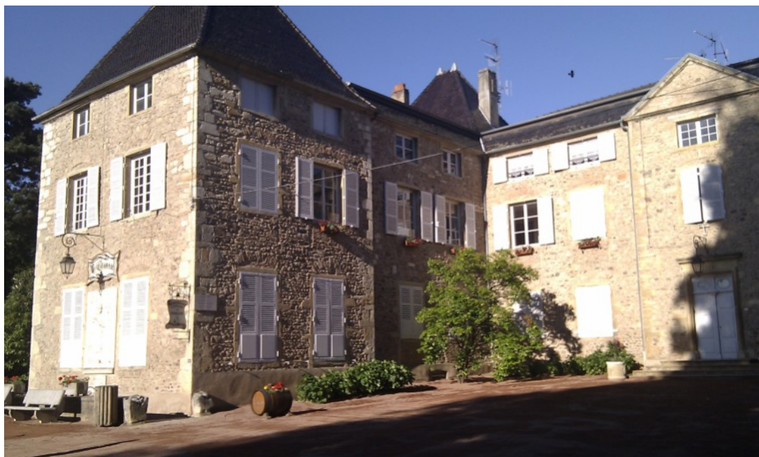
Le Château de Fontcrenne, paré de ses volets remis à neuf
