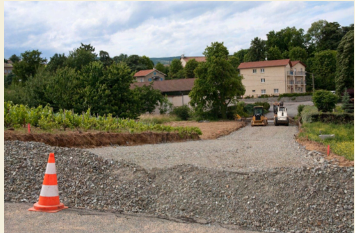
Chantier de la future voie, vu de la Maison Familiale
